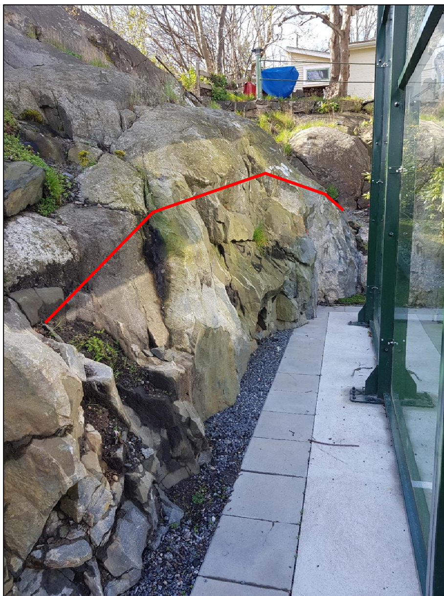
Figur 1, Fastighetens sydöstra hörn där sprängning har utförts i den nedre delen. Röd linje markerar ungefärlig nivå för sprängning.
